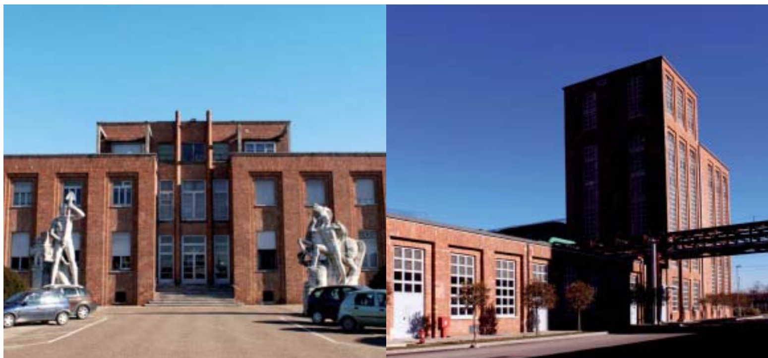
La nuova centrale di Torviscosa (UD) sorge accanto allo storico complesso Snia, è un perfetto esempio di equilibrio architettonico tra passato e presente.
