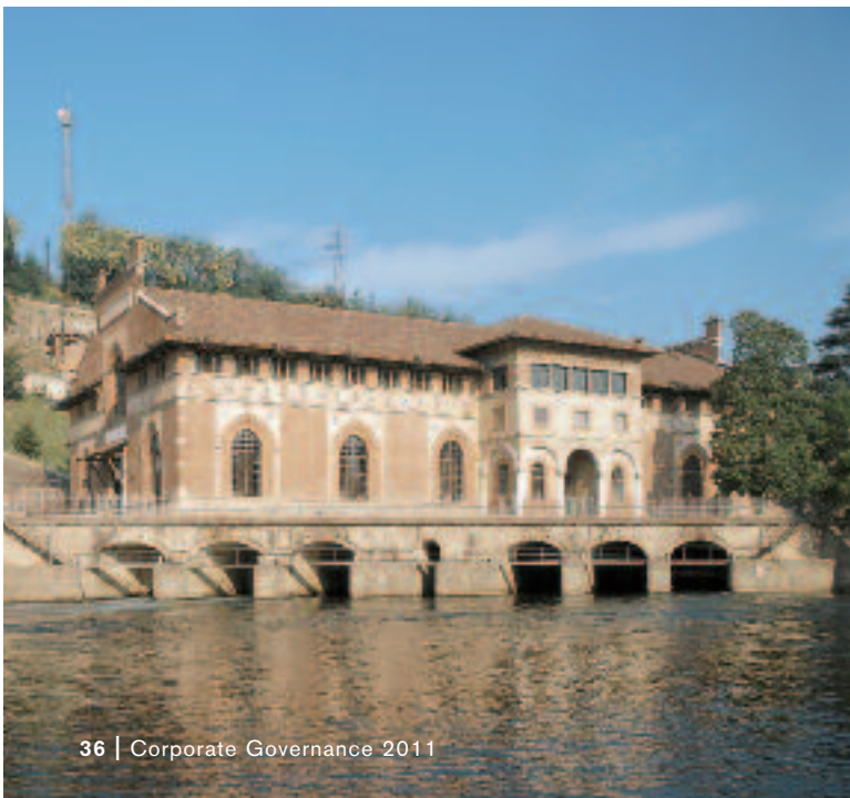
Centrale idroelettrica Esterle sul fiume Adda.
