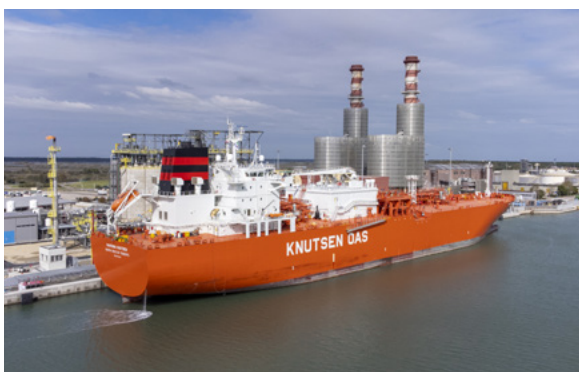
Deposito GNL - Ravenna.
